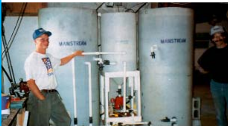
Ce premier prototype de système de traitement biologique de l'eau de surface a été installé chez un agriculteur en décembre 1993
