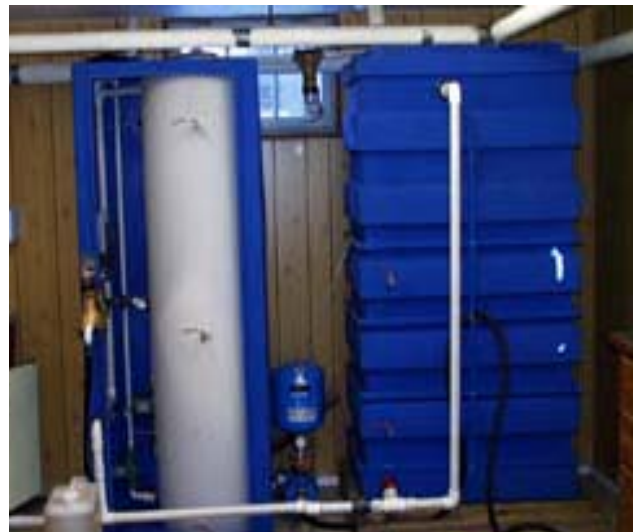
La coagulation est efficace pour enlever les particules, les métaux et les tanins.
