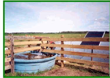
Système d'approvisionnement en eau à distance, à énergie solaire
