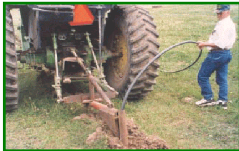
Installation d'un pipeline peu profond dans le pâturage
