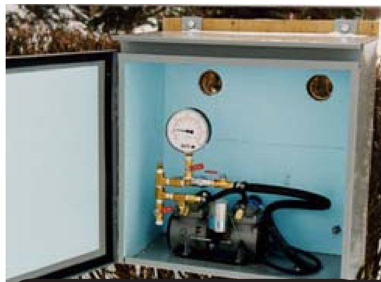
Compresseur muni d'un manomètre de pression et d'une valve de relâchement de pression installé dans un étang-réservoir
